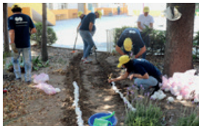
Restauración de áreas verdes en una zona de la escuela Guadalupe Victoria.
